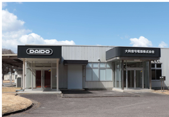
大同信号電器 新工場
